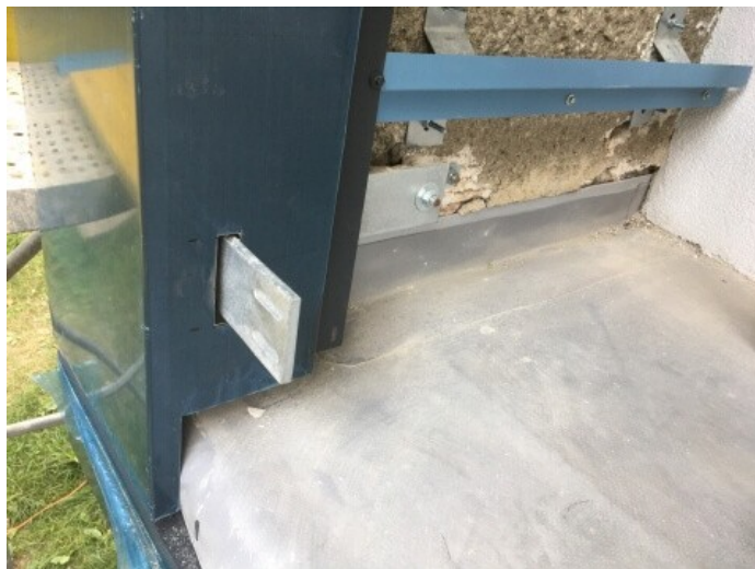
foto /14/ Osazení čelní kazety obkladu DEKMETAL na boční stěně jednoho z balkónů, s otvorem pro provlečení kotvy zábradlí.
