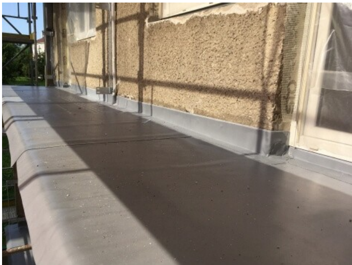
foto /9/ Hydroizolace z PVC-P tl. 1,8 mm a její ukončení u stěny a u prahu dveří, u okraje pracovní přeložení přes okraj.
