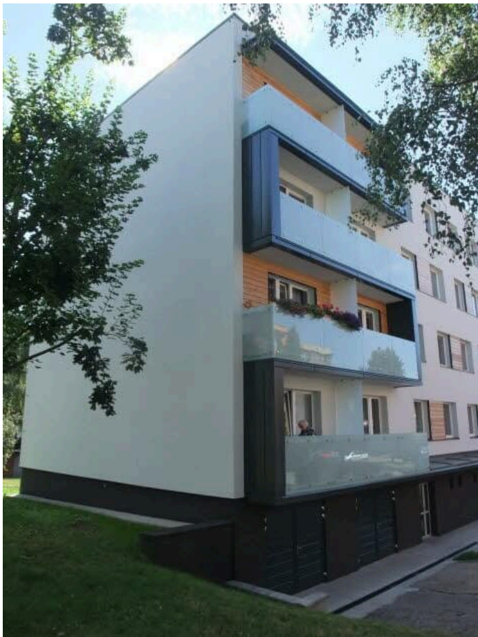
foto /1/ Dům po revitalizaci – pohled na balkóny s prostřídanou boční stěnou obloženou kazetami Dekmetal.
