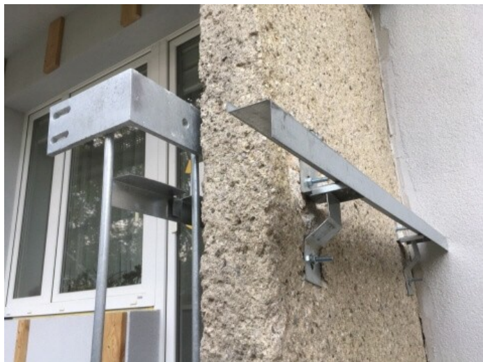
foto /13/ Vlevo kotva pro zábradlí, vpravo jednosměrný rošt pro obklad z kazet DEKMETAL. Z osazení těchto prvků je zřejmá velikost vyložení balkónů.
