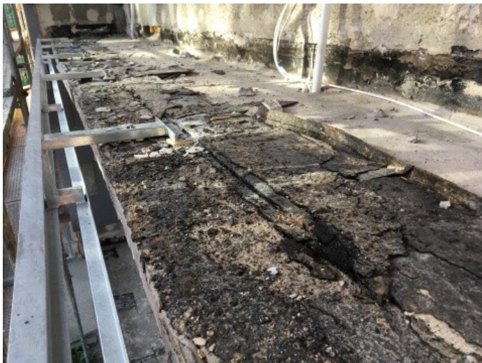
foto /7/ Rozšiřující ocelová konstrukce podporující zábradlí, skladbu podlahy a plechový pohledový obklad – po odstranění původní skladby podlahy a statické sanaci nosné balkónové desky.
