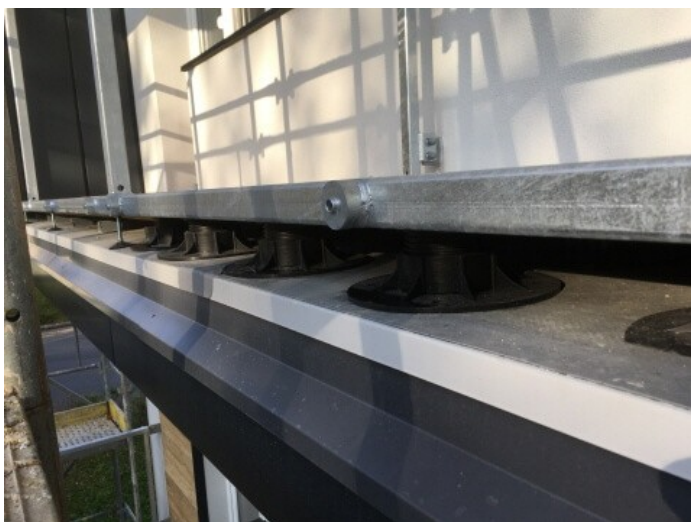
foto /11/ Teracová dlažba byla ukládána na rektifikovatelné podložky a proti vodorovnému posunu zajištěná rozepřením mezi spodní profil
