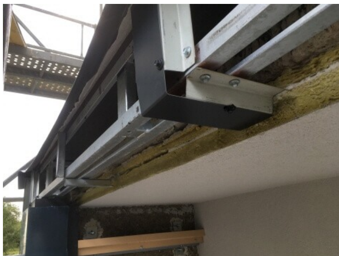
foto /15/ Podkladní profily pro kazety DEKMETAL nakotvené na rozšiřovací ocelovou konstrukci v čele balkónové desky.
