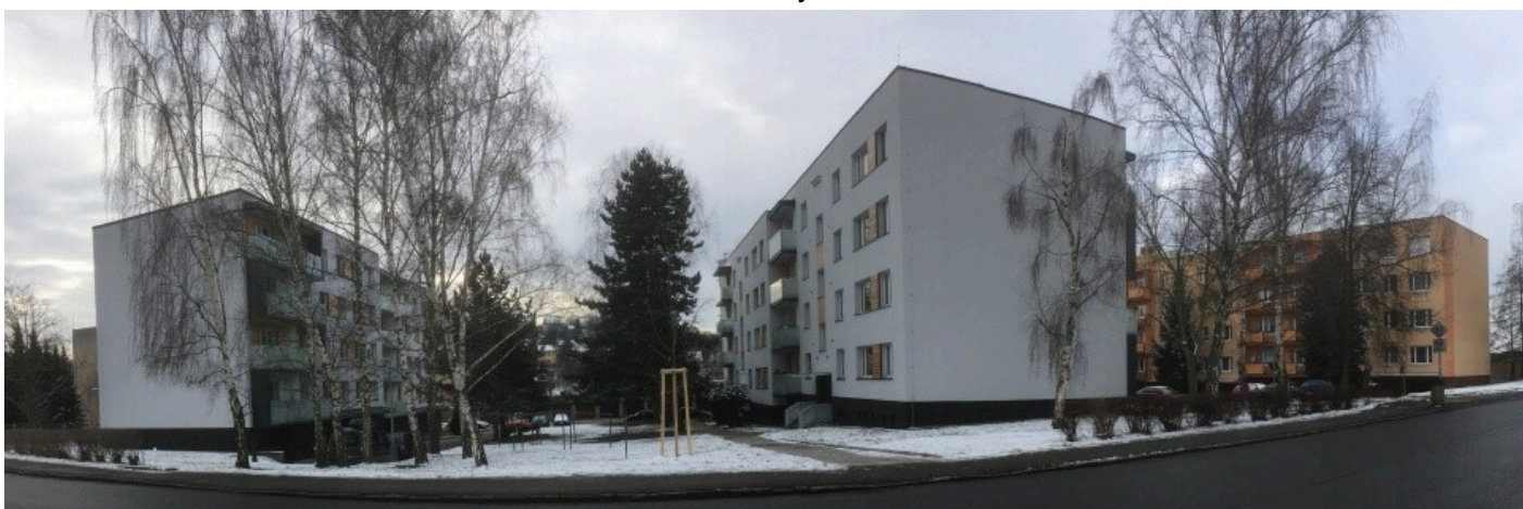
foto /19/ Pohled na revitalizovaný soubor 3 původně identických bloků panelových bytových domů.
