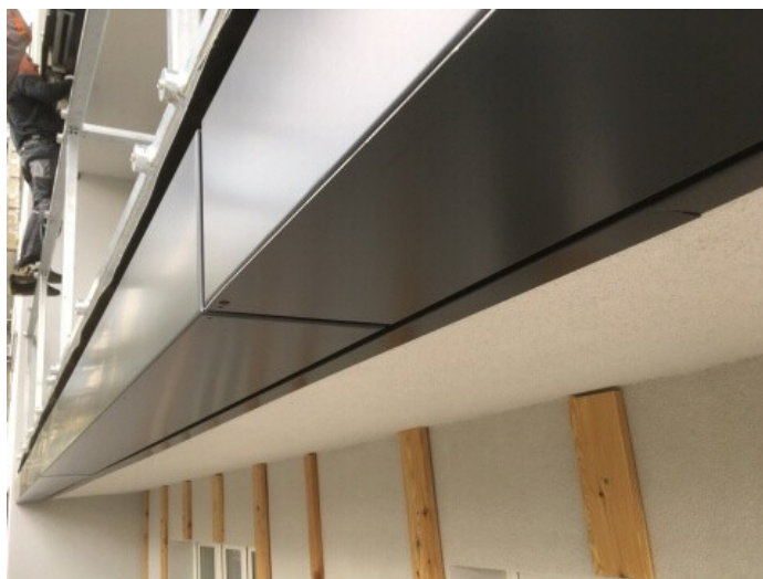
foto /16/ Finální provedení obkladu DEKMETAL na čele balkónové desky.
