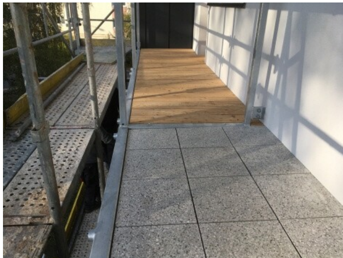
foto /10/ Někteří uživatelé chtěli pochůznou vrstvu z teracové dlažby, jiní ze dřevěných prken. V obou případech byla tato vrstva rozebíratelná, aby bylo možné hydroizolaci jednoduše zpřístupnit pro opravu v případě defektu.
