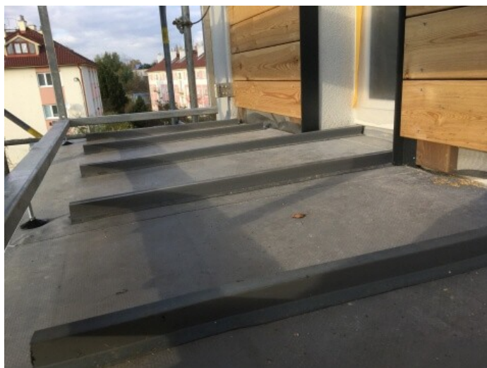
foto /12/ Distanční profily Alkorsolar využité jako podpora roštu pro pochůznou vrstvu z prken sibiřského modřínu.
