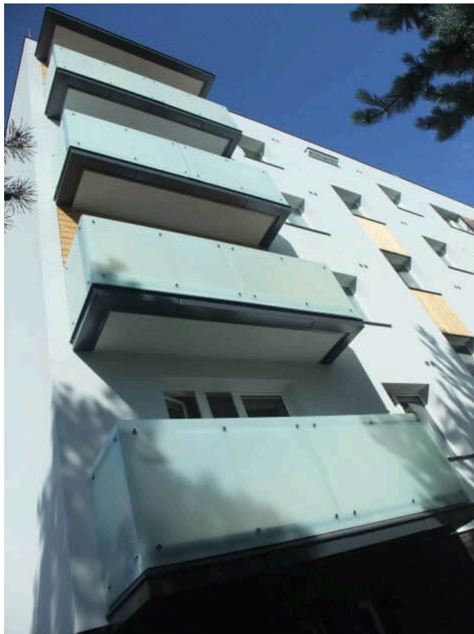
foto /2/ Dům po revitalizaci – samostatné balkóny.
